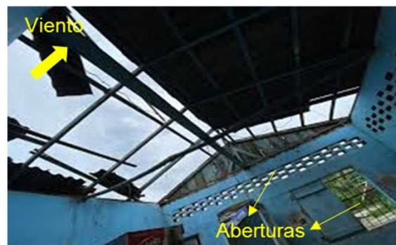
**Figura 18:** Daños en viviendas con cubiertas ligeras en Cuba [21]
