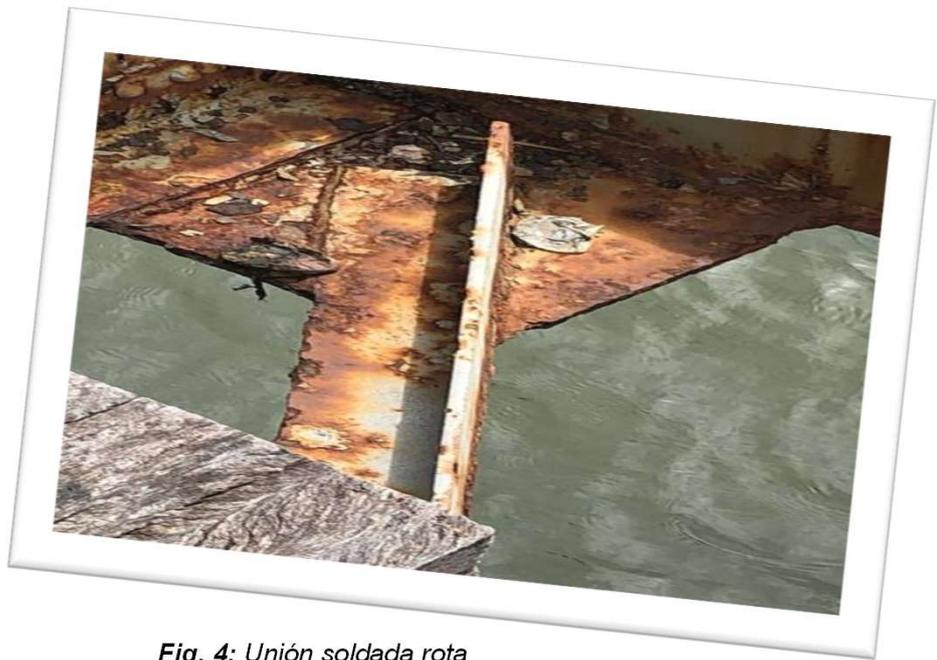
Fig. 4: Unión soldada rota
