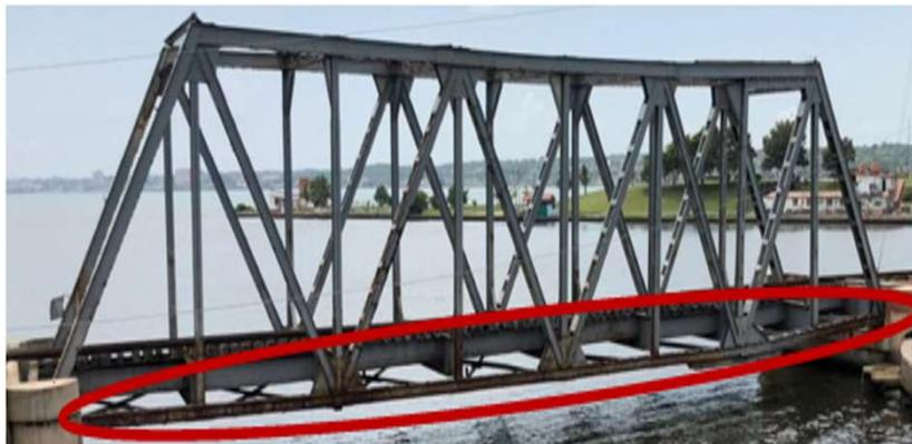
**Fig.2:** Corrosión generalizada de los miembros y uniones inferiores
