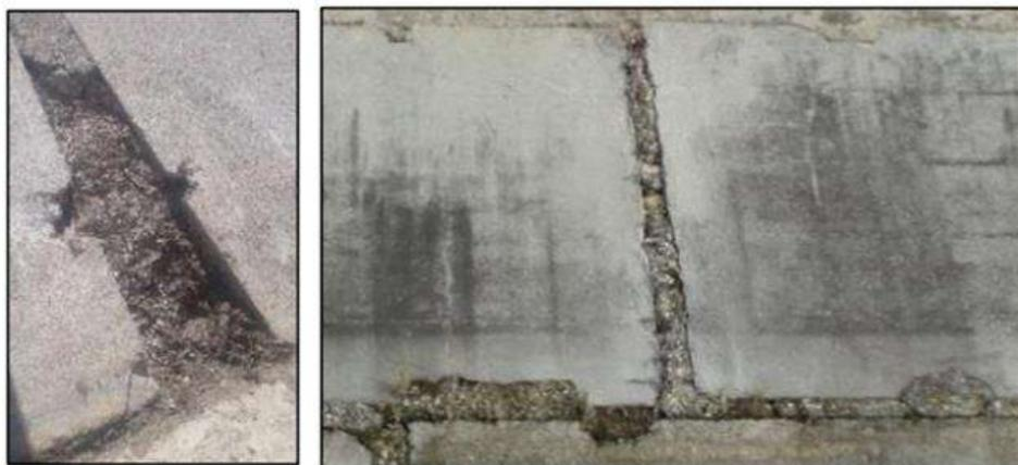
**Figura 1:** Erosión de juntas en el cuerpo de la estructura.
