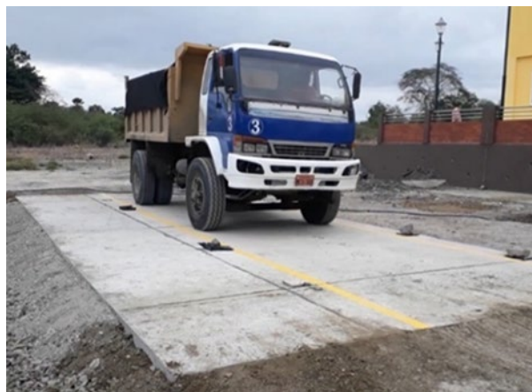
Figura 1: Tramo experimental construido en la Universidad técnica de Manabí, Ecuador [13].
