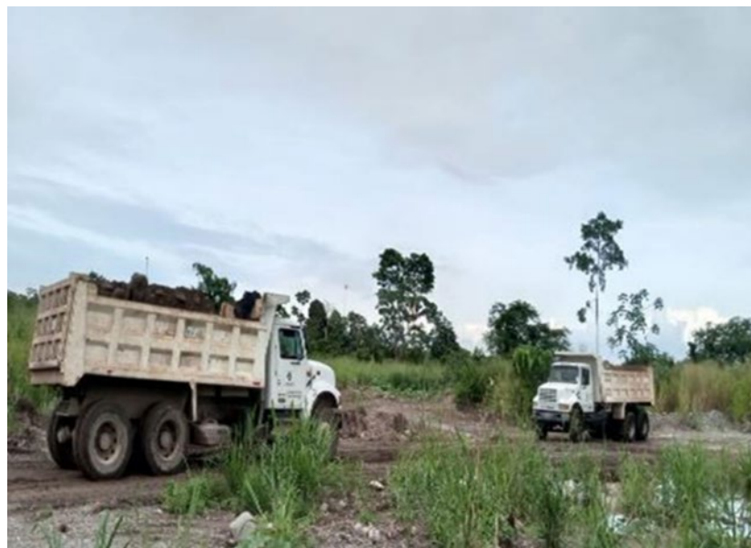
Figura 5: Transporte de material en obra Fuente: Elaboración propia
