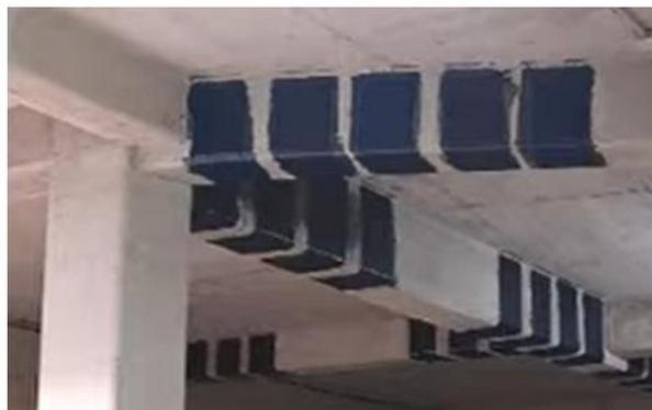
**Figura 2:** Viga de hormigón con polímero reforzado con fibras de carbono
