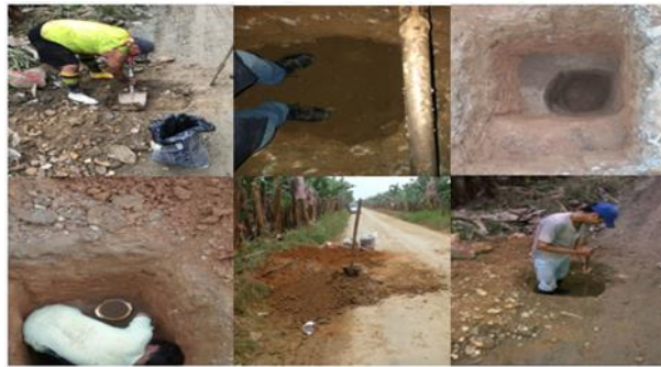
Fig. 6: Memoria fotográfica de la extracción de calicatas
