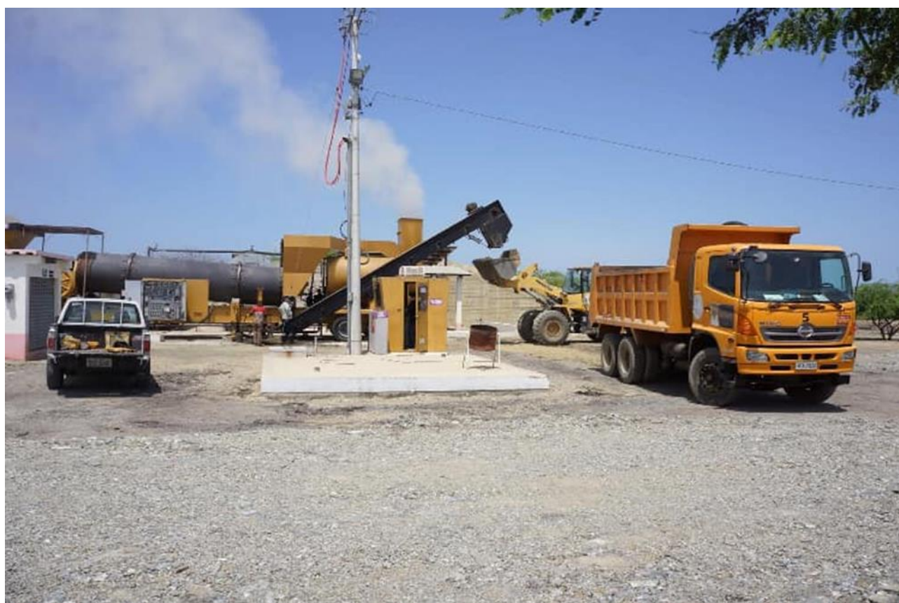
Figura 2: Planta asfáltadora del cantón Huaquillas. Fuente: GADM Huaquillas.
