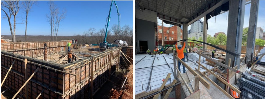
Figura 2. Uso de armadura BFRP en edificios
