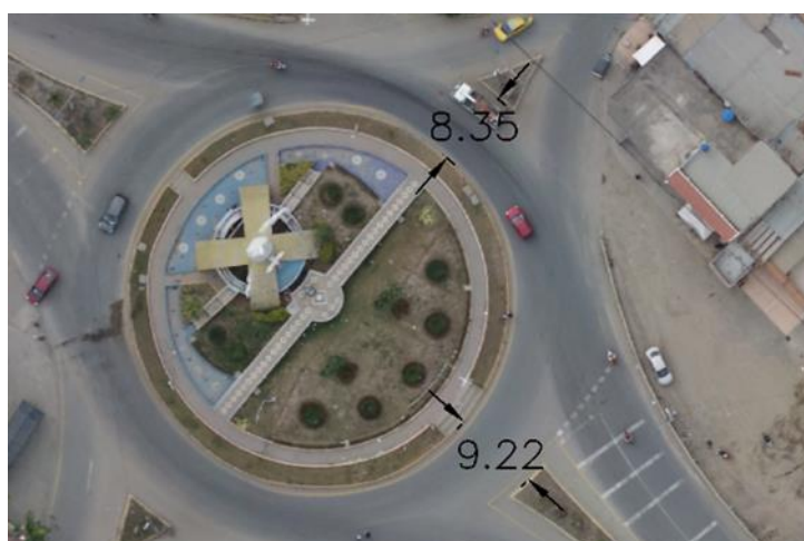
Figura 3: Ancho de circulación afectado por isletas secundarias
