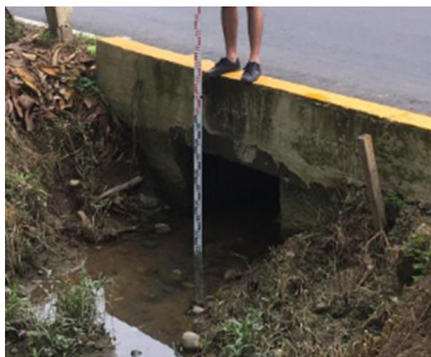
Figura 3: Estado actual de la alcantarilla
