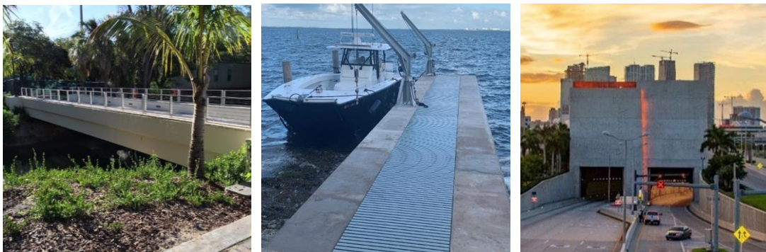
Figura 1. Proyectos de infraestructura en Florida
