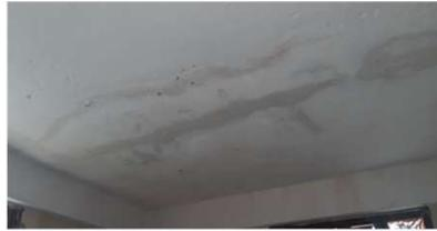
**Figura 42:** Humedad por infiltración y fisuras en el soporte estructural.
