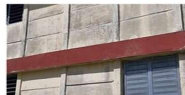
**Figura 16:** Edificio 1. Viga cerramiento del Sistema Sandino
