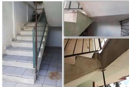
**Figura 19:** Edificio 4, escalera 1. Escalera multirrama hormigonada in situ.
