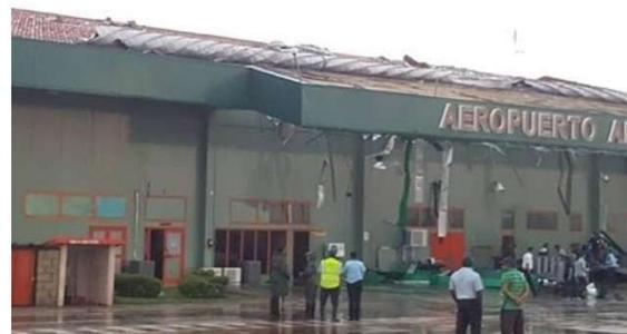
**Figura 17:** Daños en la cubierta del Aeropuerto Abel Santamaría de Santa Clara tras el paso de una tormenta [20]
