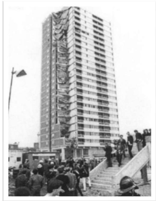
Figura 1: Colapso del edificio de apartamentos Point. (Tomado de [5])
