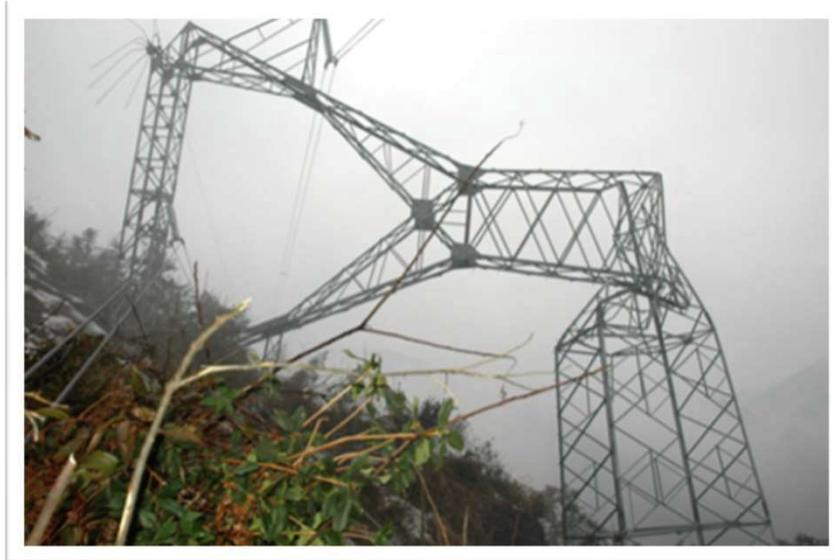
Figura 4: Colapso de una torre de transmisión eléctrica de 220 kV en China. (Tomado de [60])
