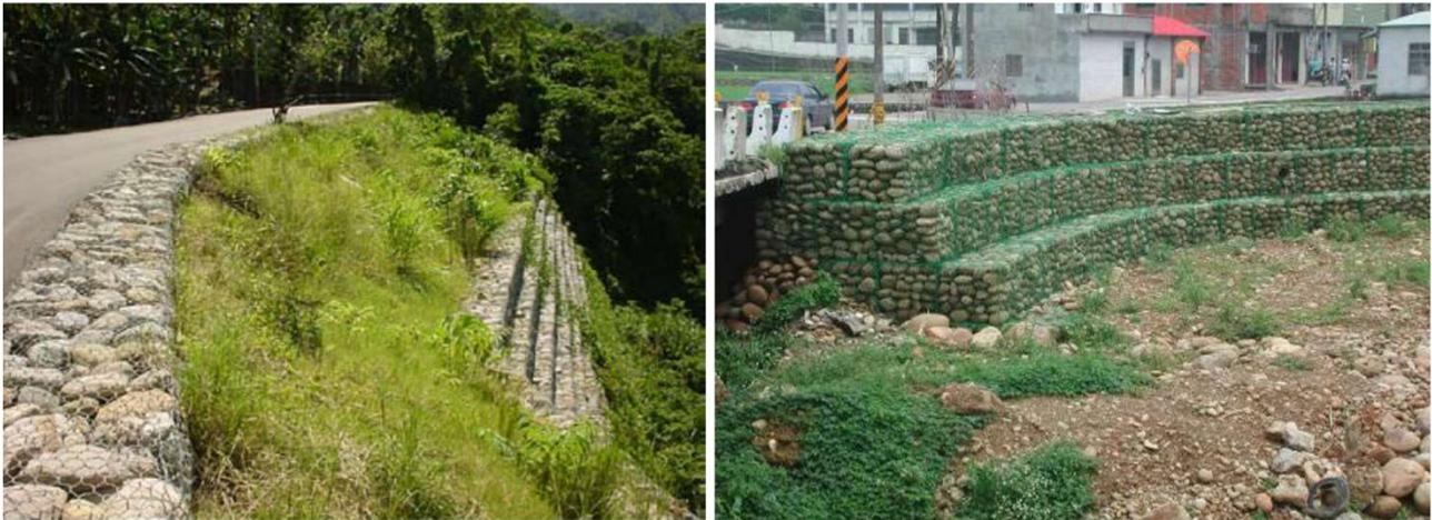
**Figura 7.** Obras de contención con empleo de gaviones en obras viales.
