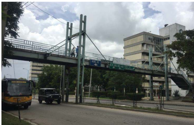
FIGURA 4: PASO PEATONAL A DESNIVEL.
