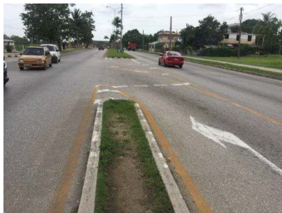
FIGURA 3: CANALIZACIÓN EN LA CALLE 114 CON LA SEÑAL DE GIRO A LA IZQUIERDA HACIA LA CUJAE.
