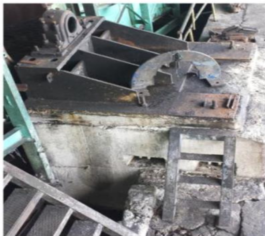
Figura 1: Base de hormigón analizada
