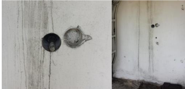
Figura 3: Extracción de testigos en la base de la maquinaria
