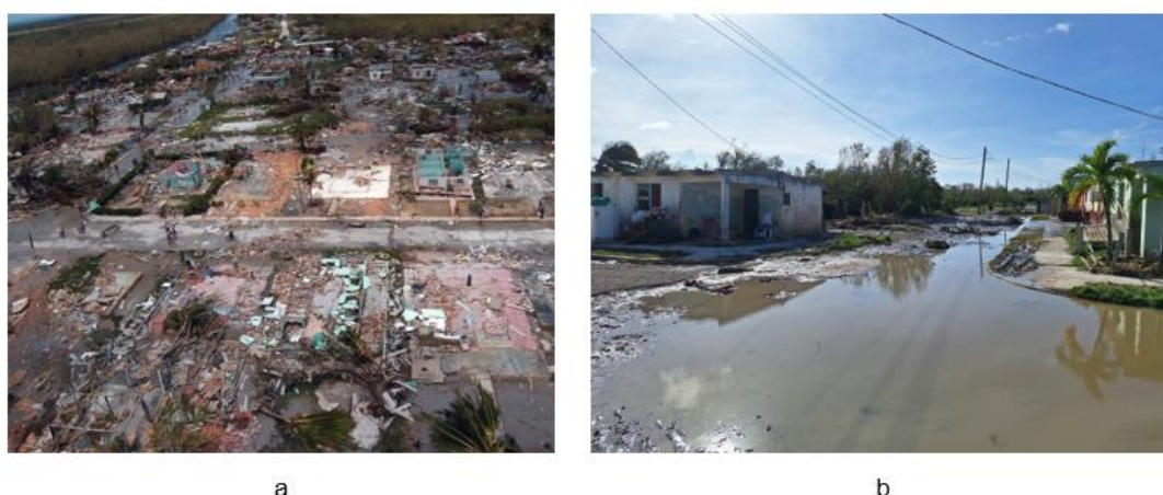
Fig. 3- Daños provocados por el paso de huracanes por la comunidad de Playa Cajío. a) Huracán Charley, 2004 (Fuente: [22]). b) Huracán Rafael 2024 (Fuente: Elaboración Propia).
