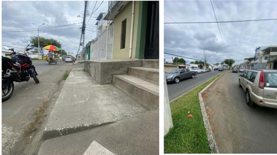
Fig. 2- Tramo con estrangulamiento de la acera
