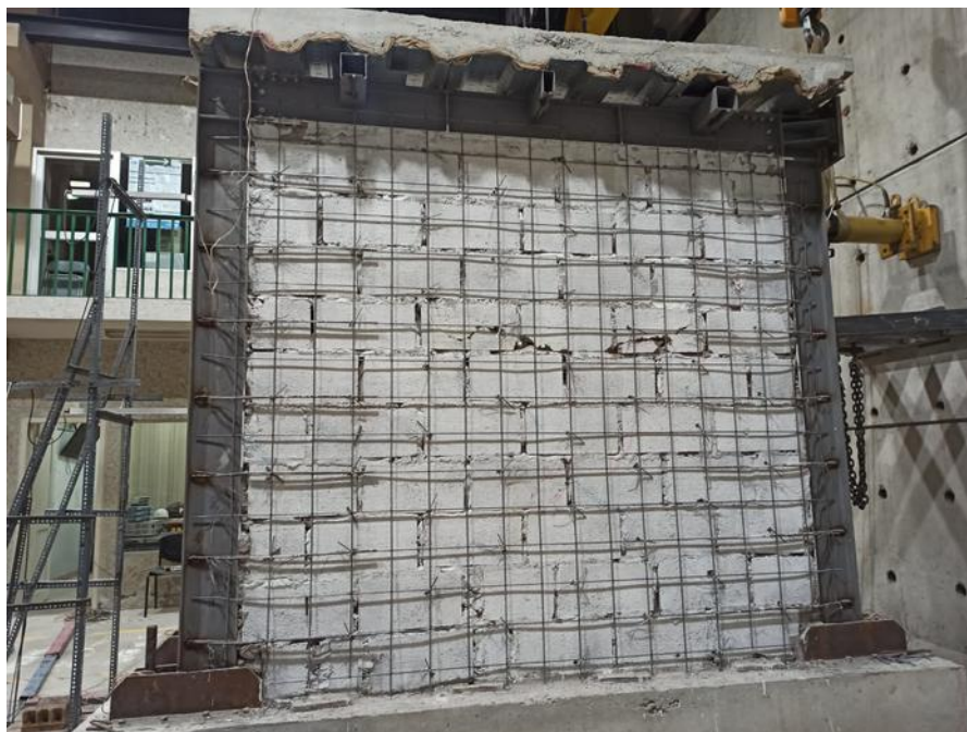
Fig. 7- Malla electrosoldada colocada en los muros de bloque en prototipo II
