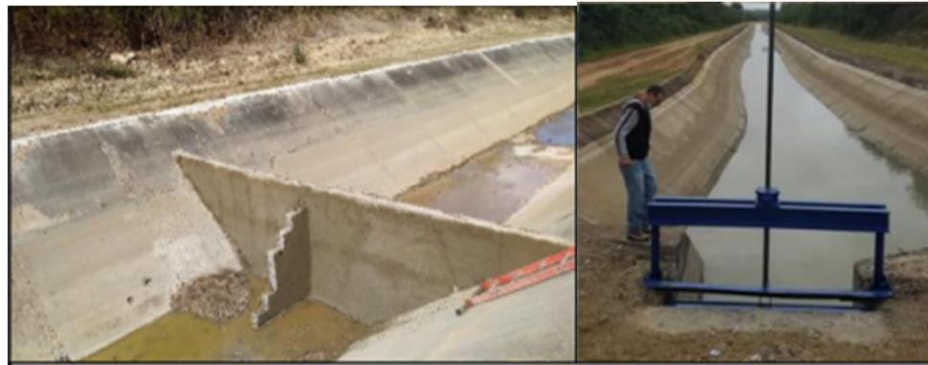
Figura 4: Cierre del tramo de canal.
