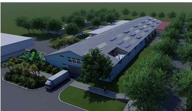
**Figura 13:** Colocación de paneles solares en la cubierta Sur de la nave.
