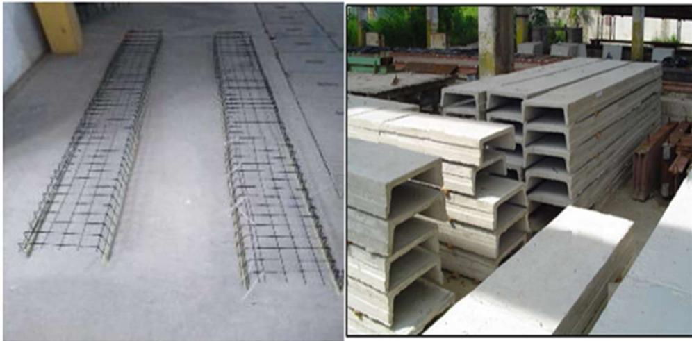
a) Armadura de refuerzo de PRFV. b) Elementos de entrepiso o cubierta.
